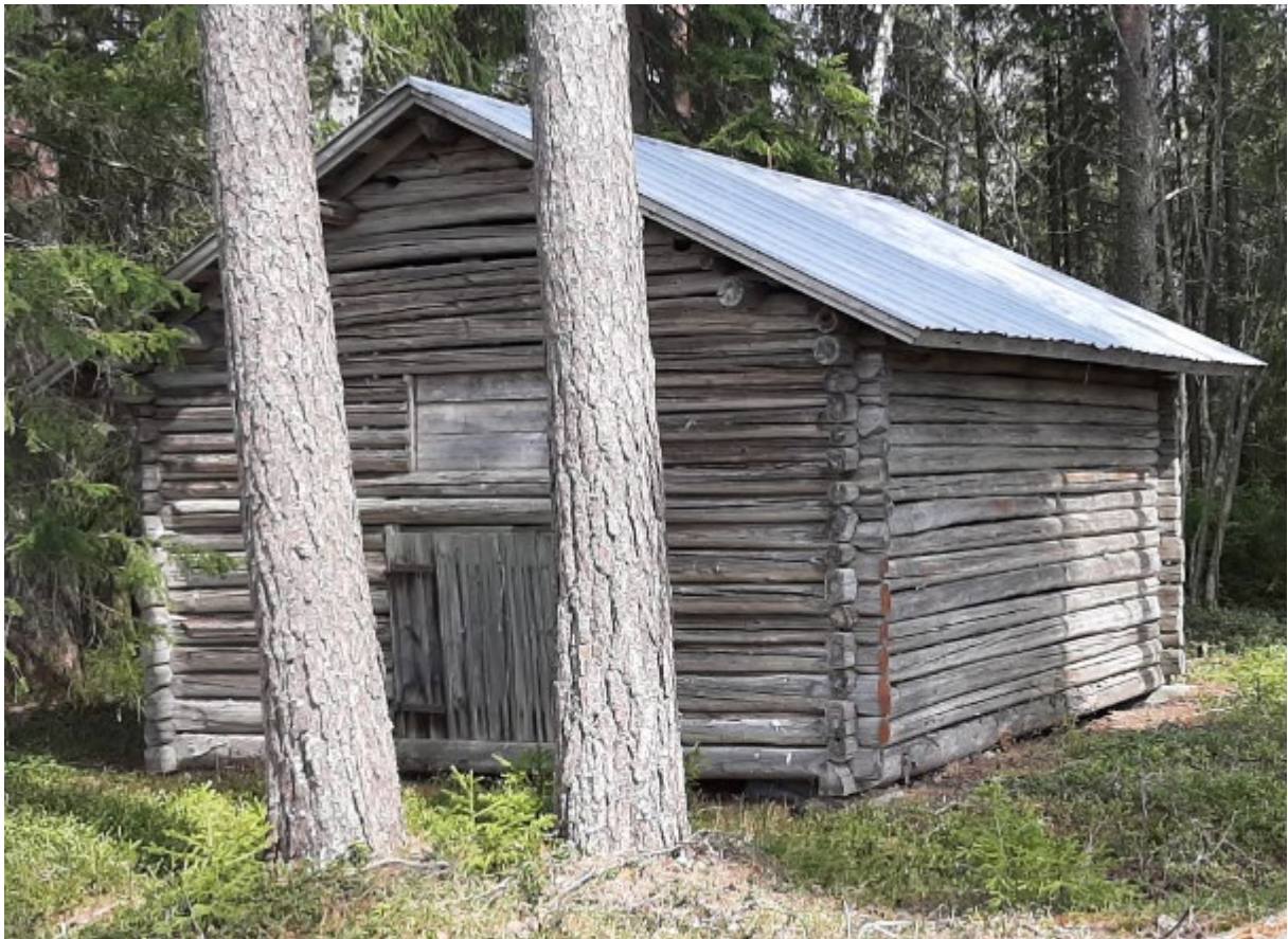
Simpukkaranta, alueella oleva hirsinen varistorakennus, n. 20 m2.
